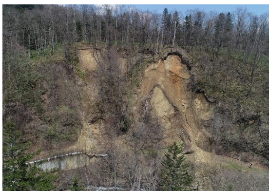
着手前全景 U A V 撮影 (空撮)
