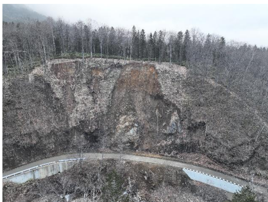
完成全景 U A V 撮影 (空撮)
