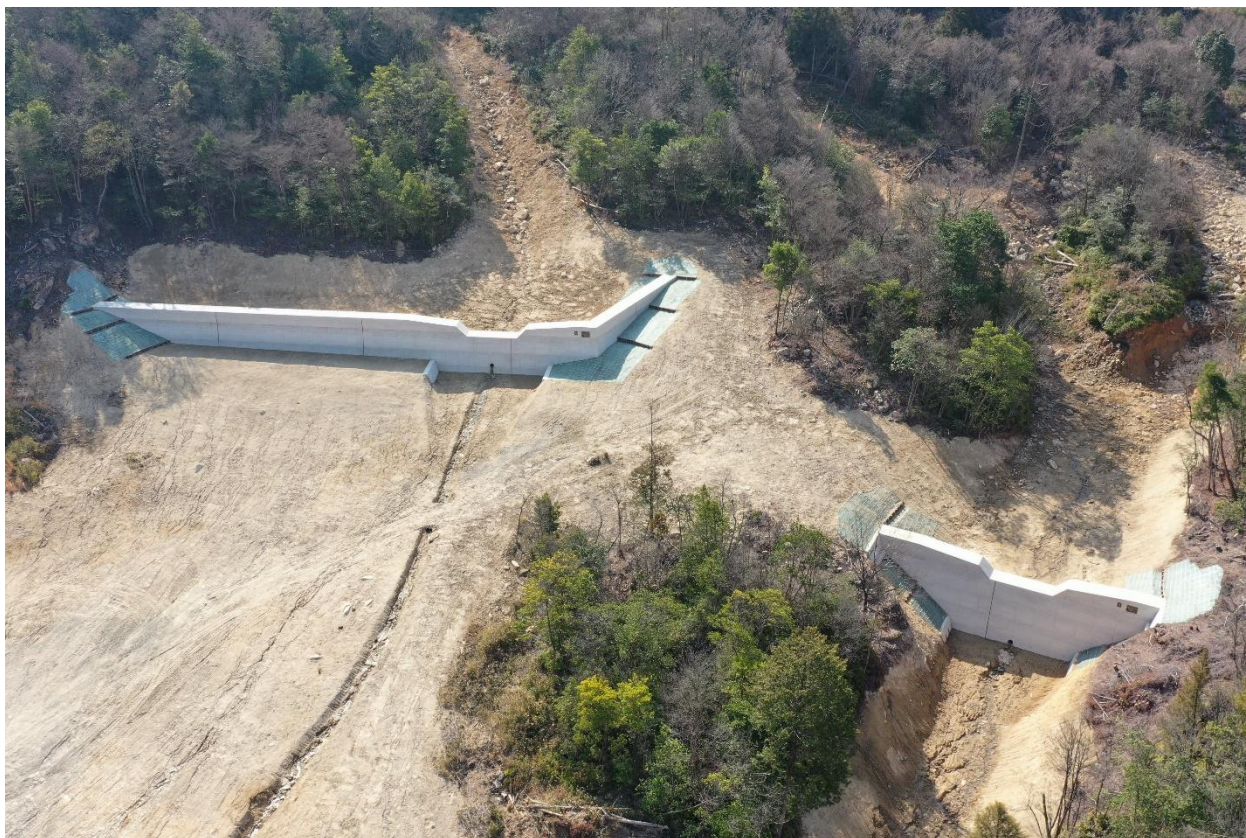
令和7年度林野庁治山・林道工事コンクール 農林水産大臣賞受賞工事 黒瀬（ケ-22ほか）溪間工事 廣濱建設株式会社（大阪林業土木協会）
