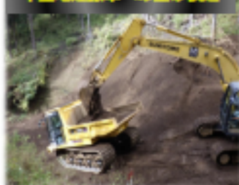
不整地運搬車への土砂積込
