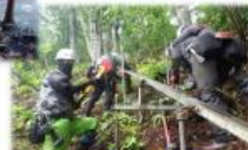
レールの架設作業
