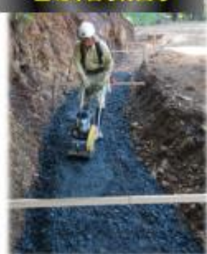
基礎砕石の締め
