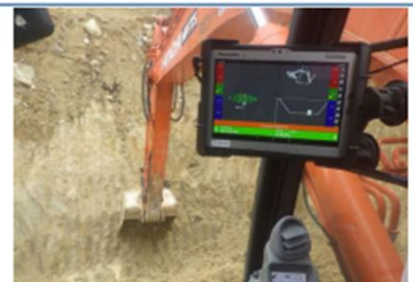
自動追尾式トータルステーションを活用したICT建設機械の活用
