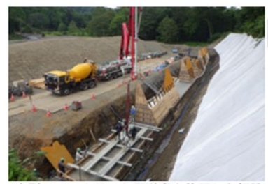
大型のコンクリート圧送車を使用した打設
