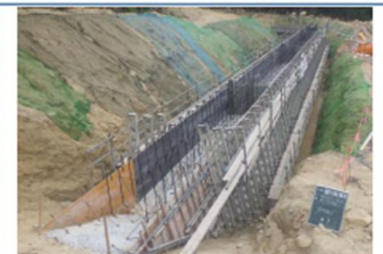
レールに沿って型枠や足場を上昇させることができるスライド型枠を採用
