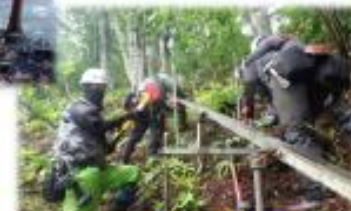
レールの架設作業
