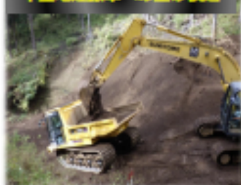
不整地運搬車への土砂積込
