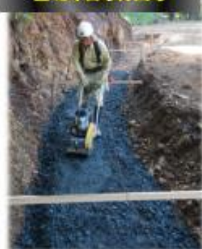
基礎砕石の締め
