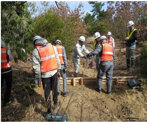
土砂流出防止策（木柵）施工中
