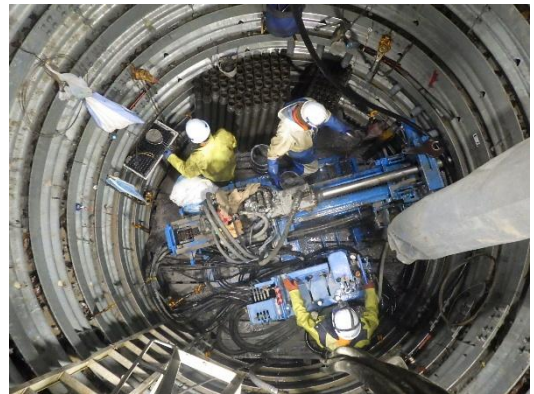
地すべり工事の施工状況
