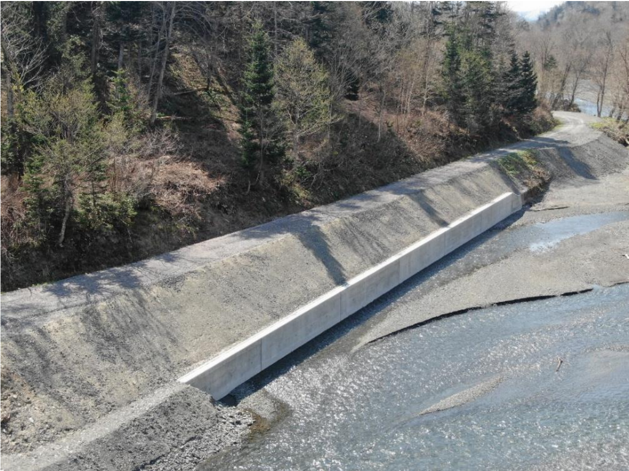
令和7年度林野庁治山・林道工事コンクール農林水産大臣賞受賞工事 奥名寄林道災害復旧工事 新谷建設株式会社（旭川林業土木協会）
