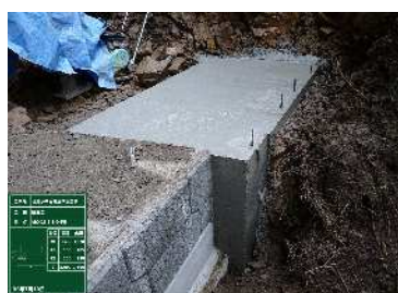
・ 段上り部コンクリート
