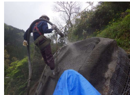
ザルコン吹付状況
