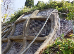
枠内補強金網敷設状況
