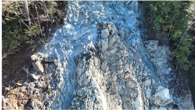
繊維補強モルタル吹付状況
