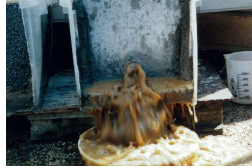
モルタル吹付工
