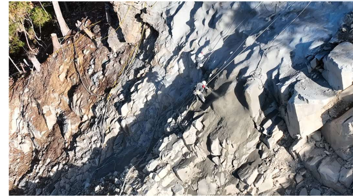
繊維補強モルタル吹付状況
