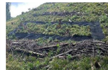
特殊樹脂ネットの設置
