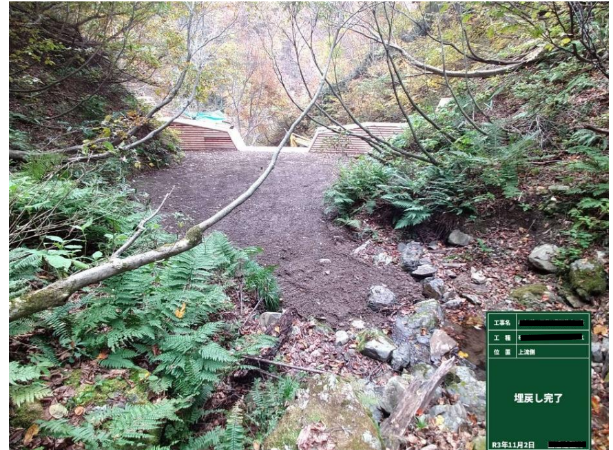
【写真2】 ダム背面への埋戻し状況 埋戻しをしっかり行っている。
