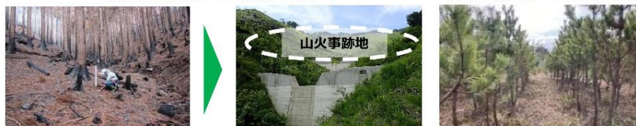
山火事跡地における森林土壌調査を踏まえた治山ダムの設置
