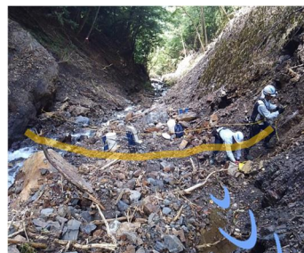
土石流センサー の設置 (日義国有林)
