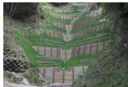
山腹工(東濃署)
