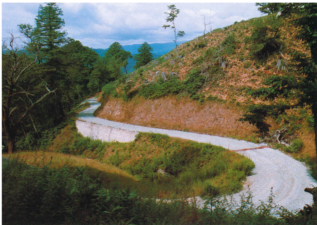
名古屋営林局下呂営林署 西俣本谷林道新設工事
