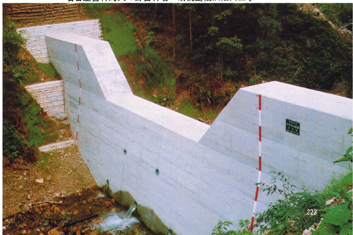
名古屋営林局久々野営林署 胡桃島復旧治山工事
