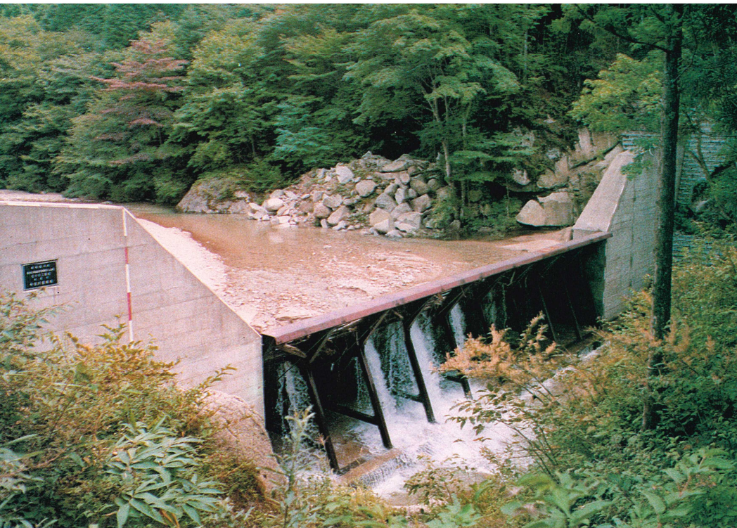
名古屋営林局中津川営林署 阿木川災害復旧治山工事
