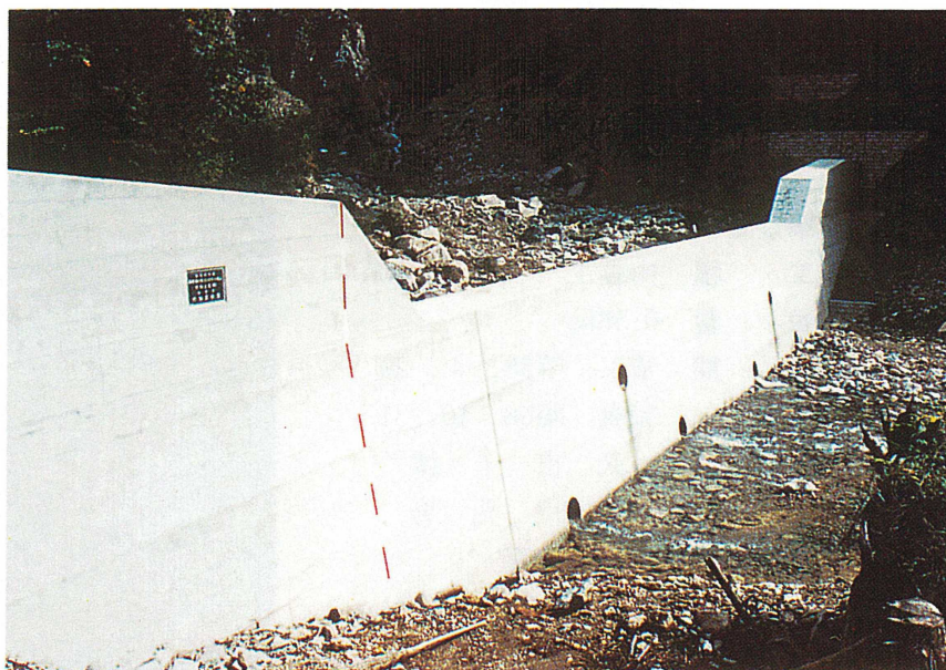
名古屋営林支局付知営林署 高樺復旧治山工事
