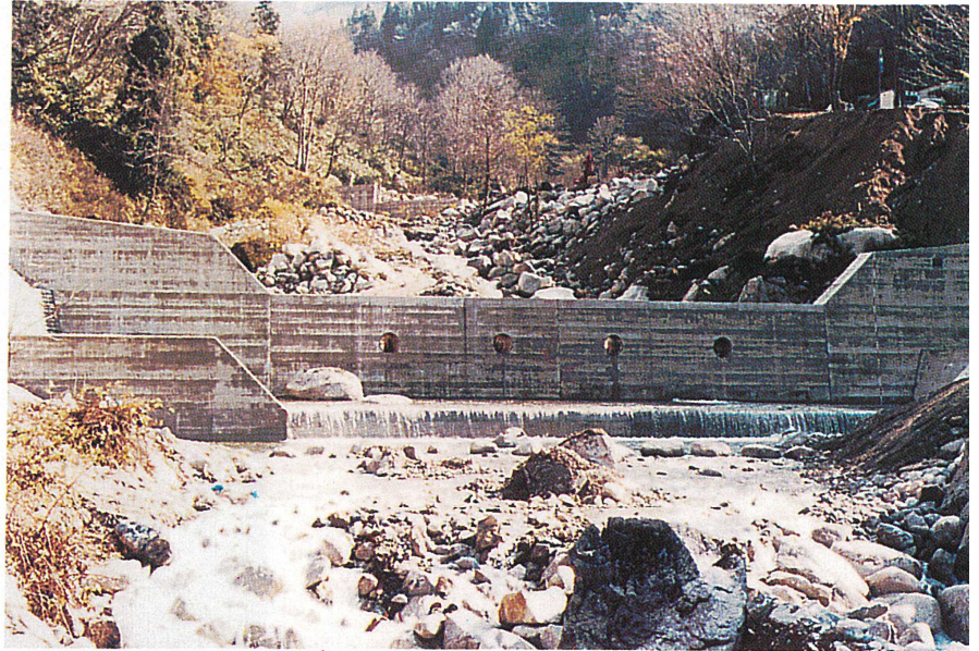
名古屋営林支局富山営林署 南又谷(その2)復旧治山工事
