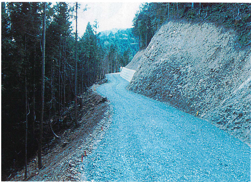
名古屋営林支局下呂営林署 厚谷・神割(神割側)新設工事
