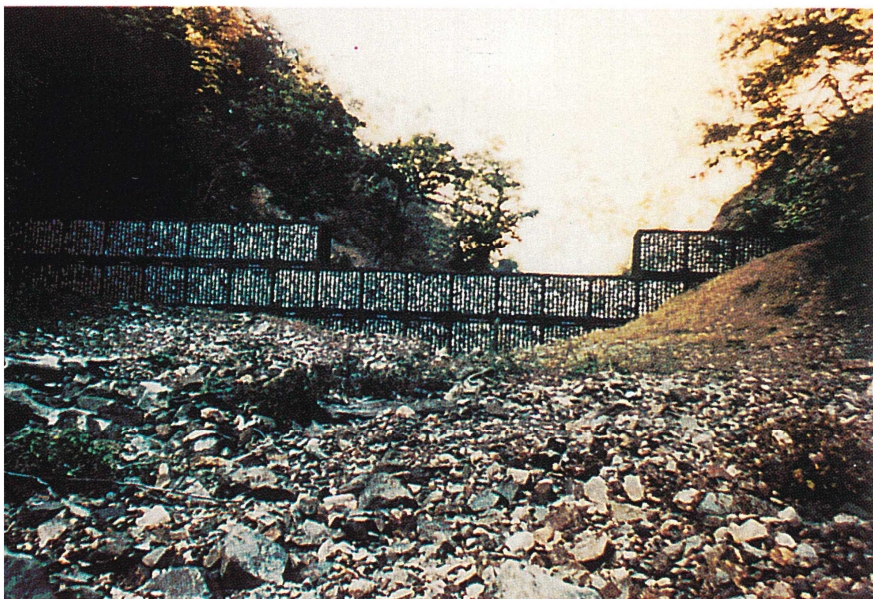
名古屋営林支局岐阜営林署 越波（河内谷）復旧治山工事
