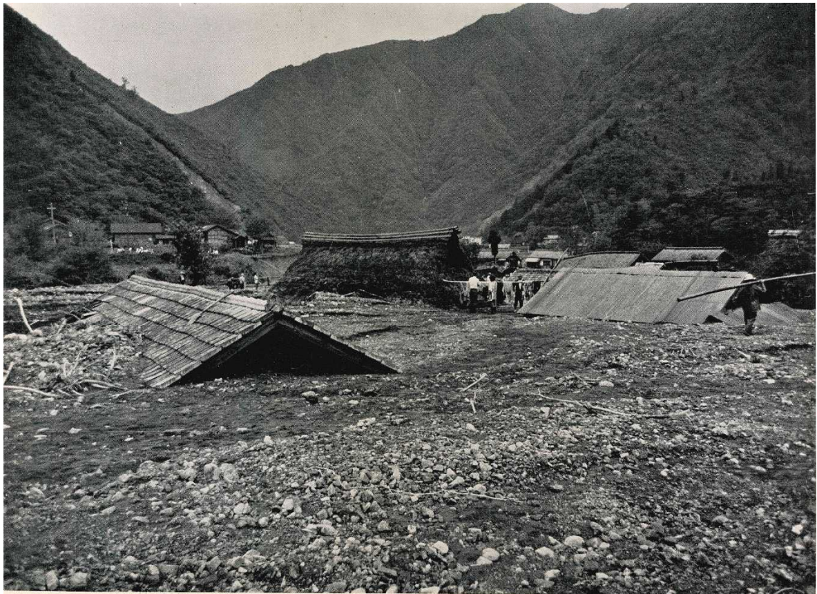
昭和40年9月の台風で土石流のため埋没した岐阜県下の農家。豪雨を契機として土砂で家屋が埋没する場合、山崩れの直撃を受けて起こること、山崩れで生まれた土砂が一たん谷底に堆積して、それが二次的に流動し土石流となって被害をあたえることがある。この山地災害は後者の例である。
