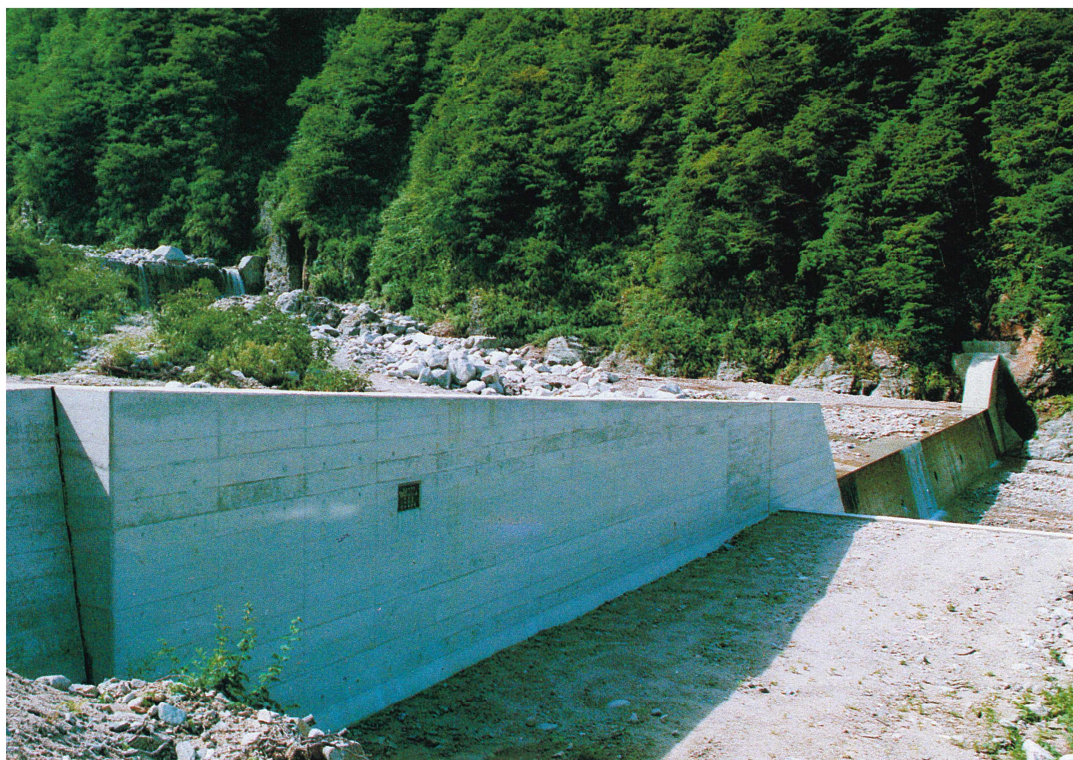
名古屋営林局富山営林署 阿部木谷崩壊地復旧治山工事
