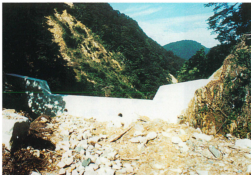
名古屋営林支局富山営林署 西又谷復旧治山工事
