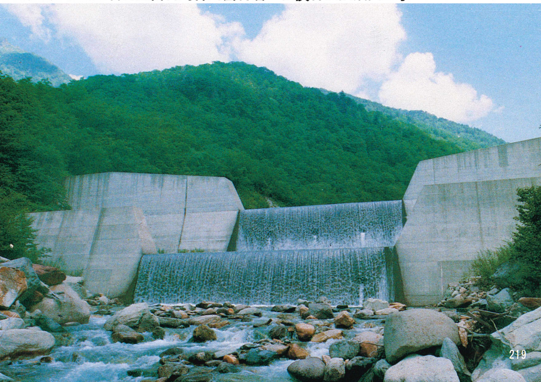
名古屋営林局神岡営林署 左俣谷復旧治山工事
