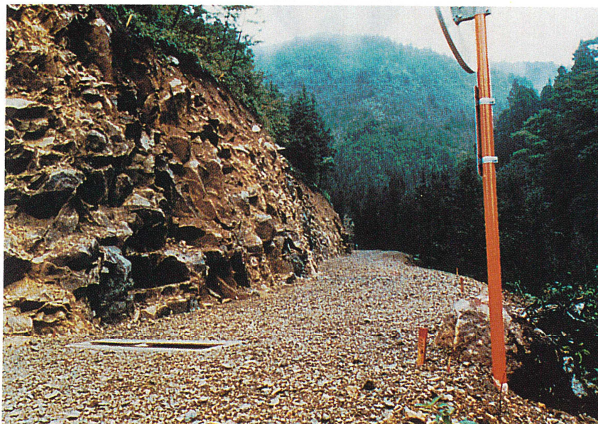
名古屋営林支局古川営林署 瓜巢林道新設工事
