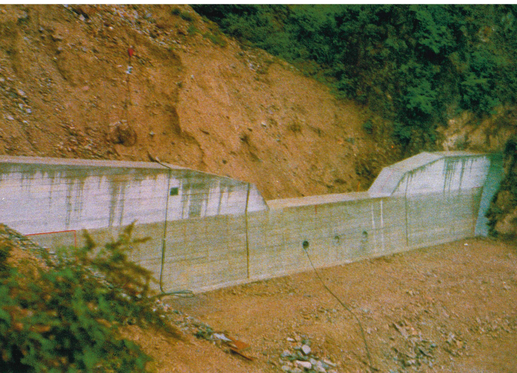
名古屋営林局荘川営林署 間名古屋谷復旧治山工事
