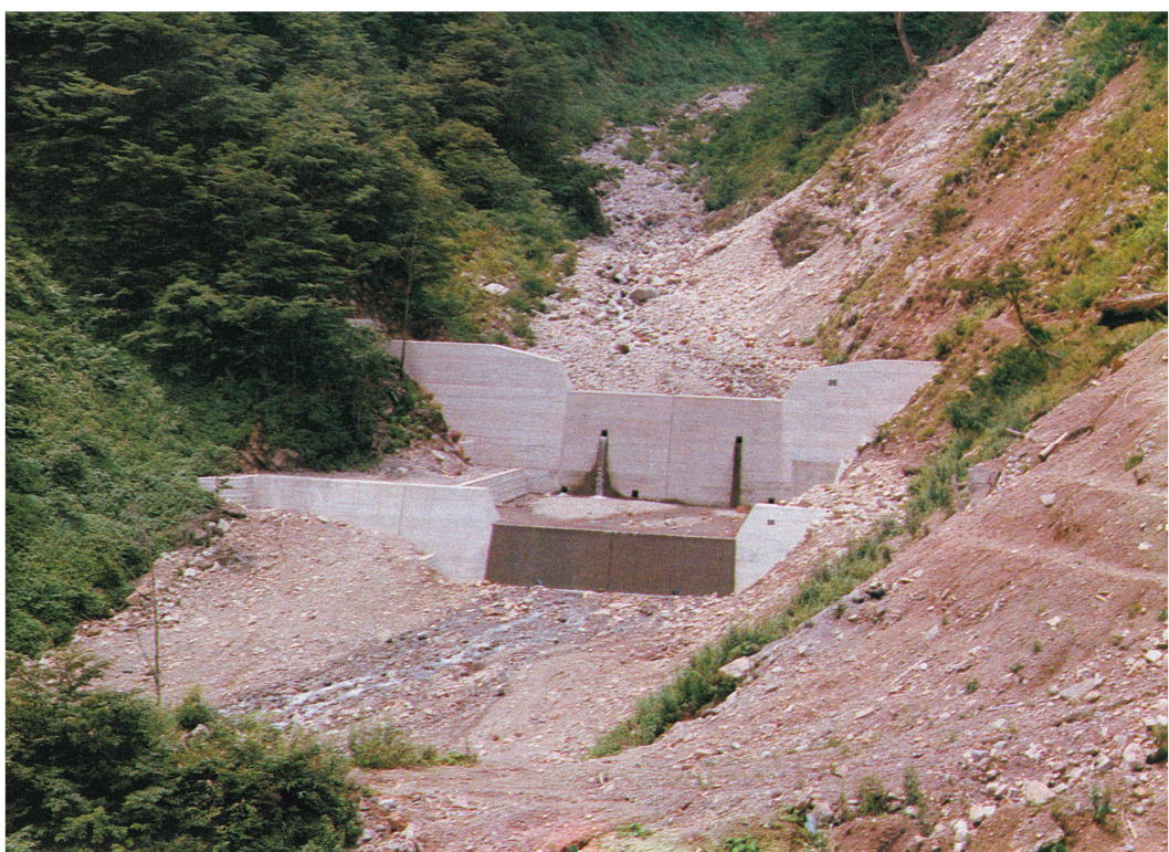
名古屋営林局岐阜営林署 能郷谷復旧治山工事
