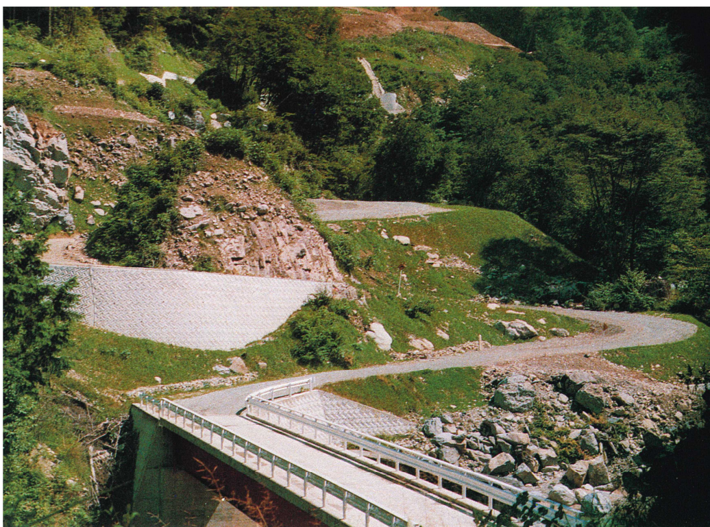
名古屋営林局付知営林署 牛首林道新設工事
