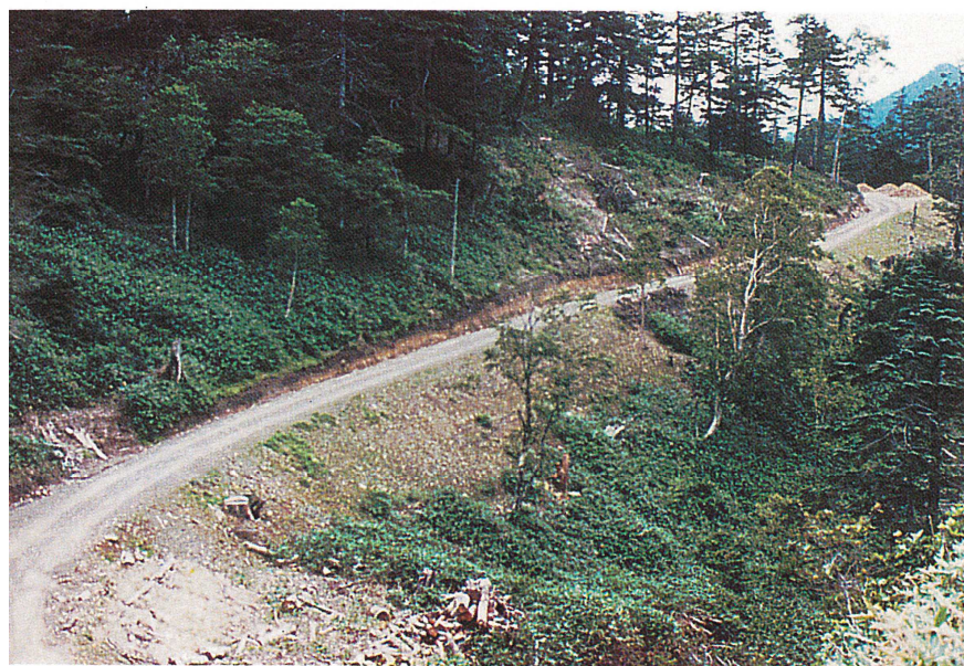
名古屋営林支局久々野営林署 脇谷林道新設工事
