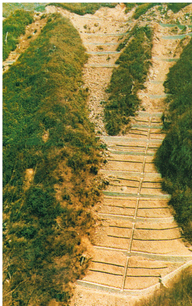
名古屋営林局小坂営林署 榎谷復旧治山工事
