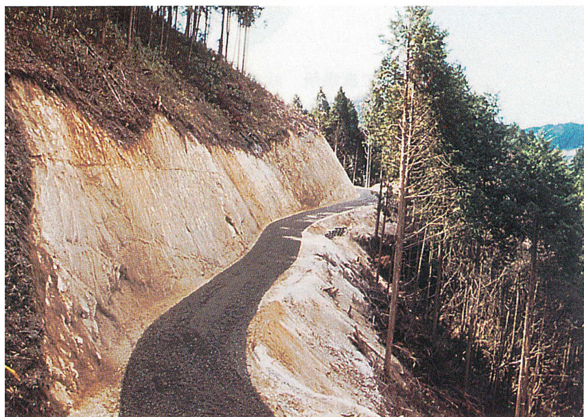
名古屋営林支局中津川営林署 桧根林道新設工事
