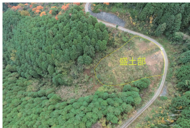
写真－５ 盛土の現況の俯瞰写真（琴南財田５－１号線）
