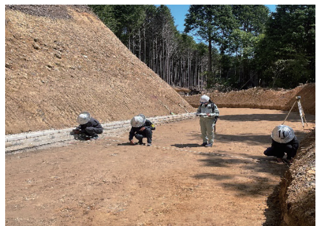
現場確認の様子
