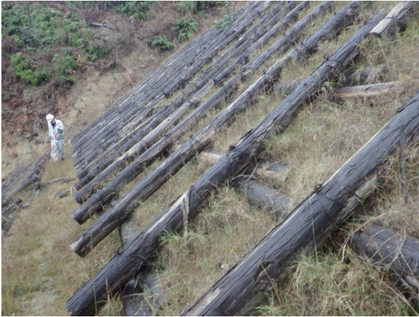
写真－２ 盛土点検実施状況
