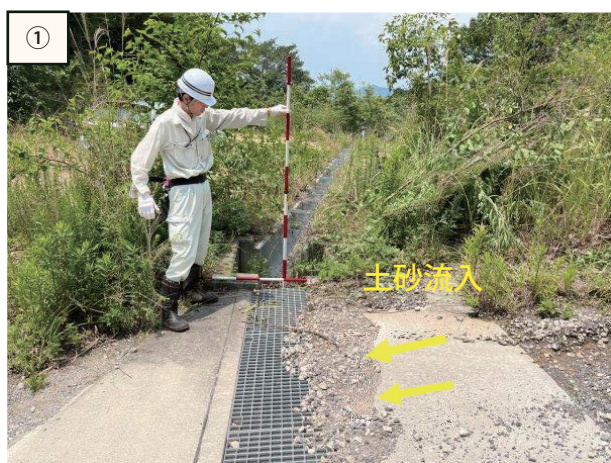
図－3 調査箇所における異常の状況と土砂や転石の推定流入経路（琴南財田3－1号線 箇所番号8）
