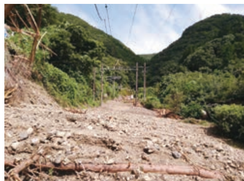
被災状況（肥薩おれんじ鉄道）
