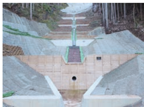
復旧状況（山腹工）
