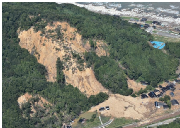
写真4 地震被害箇所の大雨による土砂流出 (石川県珠洲市)
