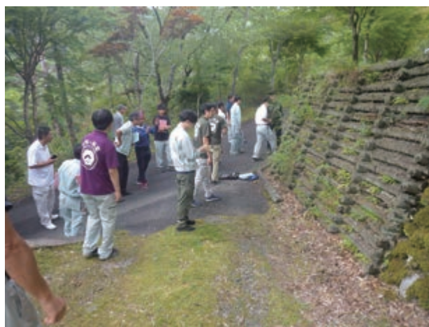
写真3 20年程度前に施工された木製土留工の見学
