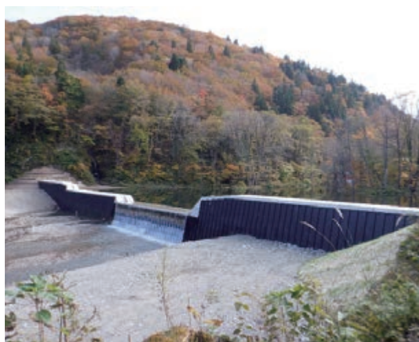
(谷止工完成状況)
