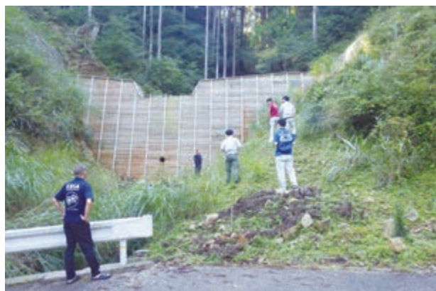
写真2 既存木材利用施設の見学（景観に配慮した残存型枠）
