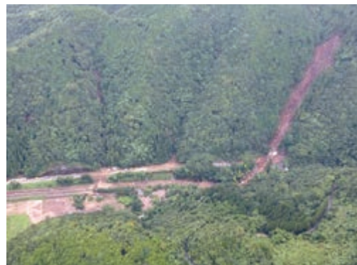
被災状況（全景）
