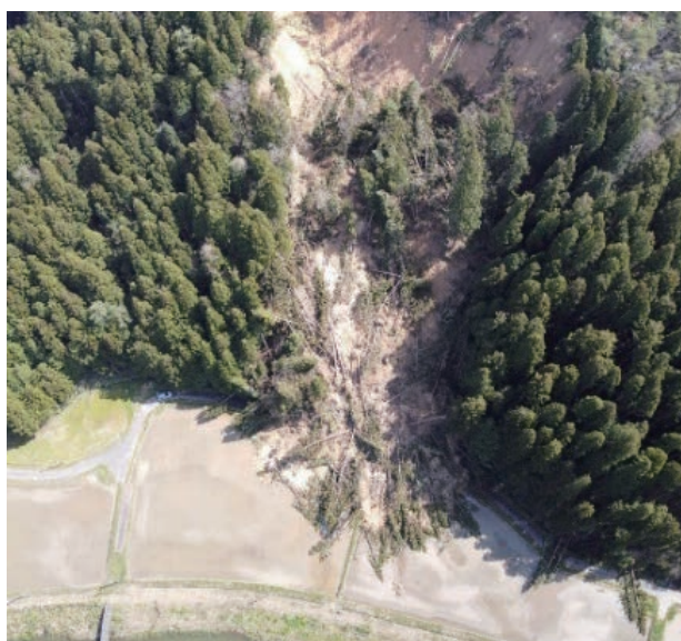
写真2 地震による山腹崩壊 (石川県珠洲市)
