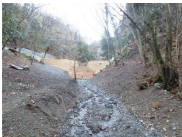
写真-1 治山ダムの設置と溪流内の危険木の伐採・搬出
