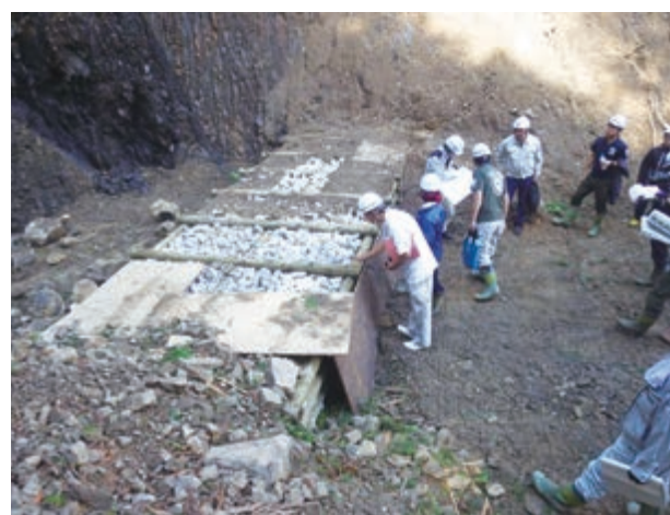
写真1 現地研修 施工中の木製校倉式治山ダムの見学
