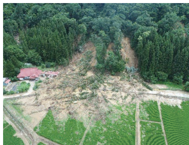
写真3 大雨による山腹崩壊 (山形県戸沢村)
