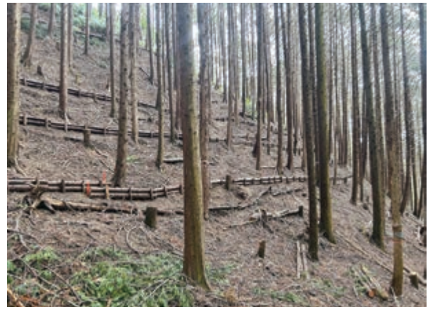
写真-2 本数調整伐と筋工の整備状況
