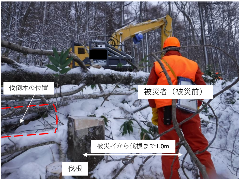
被災箇所の位置関係（被災者側から）
