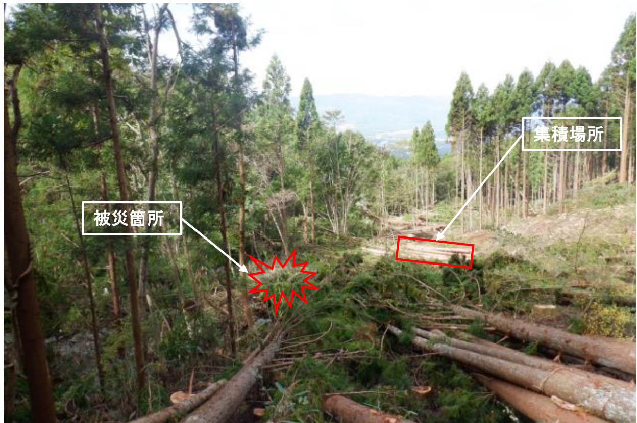
被災箇所上方からの状況
