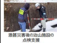
激甚災害後の治山施設の点検支援
