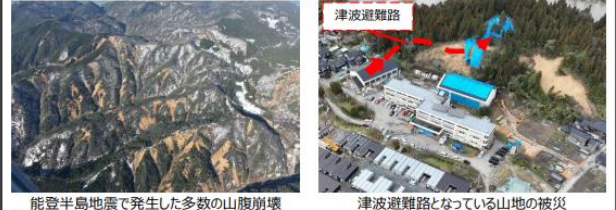
能登半島地震で発生した多数の山腹崩壊
