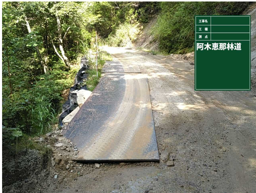
大型土嚢で路肩を仮復旧した箇所（現在運材中） R6.8
