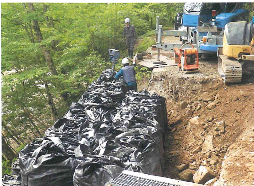
若栃榎谷林道（下） 令和3年6月10日 崩壊箇所仮復旧状況
