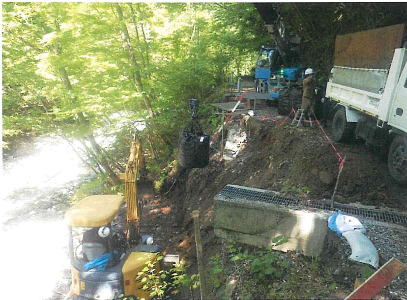
若栃榎谷林道（下） 令和3年6月2日 崩壊箇所仮復旧状況
