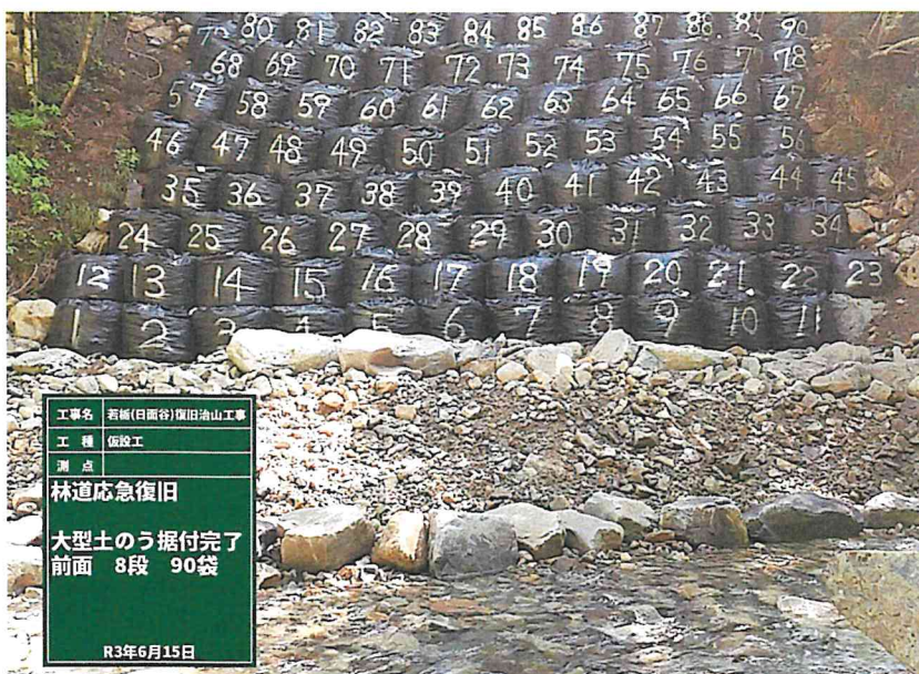
若瀬榎谷林道（下） 令和3年6月15日 崩壊箇所仮復旧完了 対岸側から撮影
