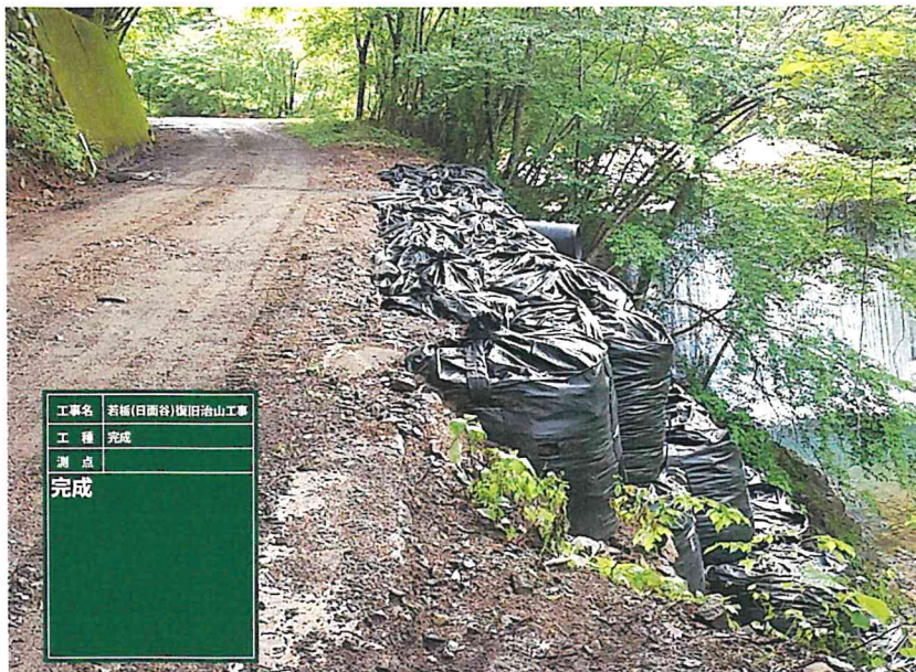
若樺榎谷林道（下） 令和3年6月15日 崩壊箇所仮復旧完了 下流側から撮影
