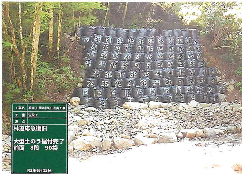
若瀬榎谷林道（下） 令和3年6月15日 崩壊箇所仮復旧完了 対岸側から撮影
