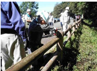
駐車場の木柵交換作業
