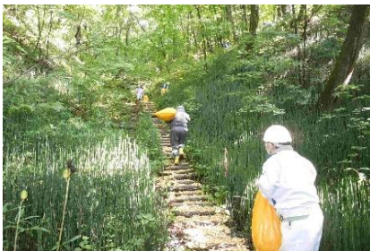
ウッドチップの敷設作業
