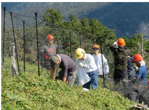
植生保護策の設置作業（上下）
