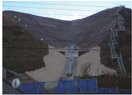
雪崩柵再設置荷揚通路の設置
