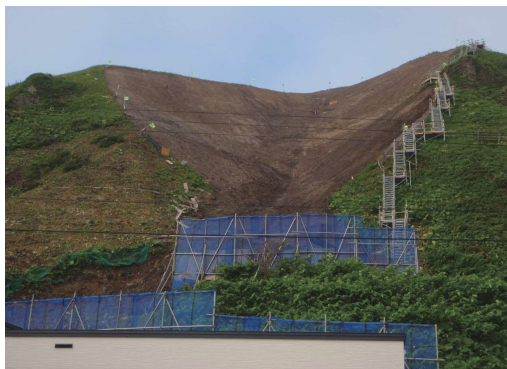
RCM法面切土・整形
