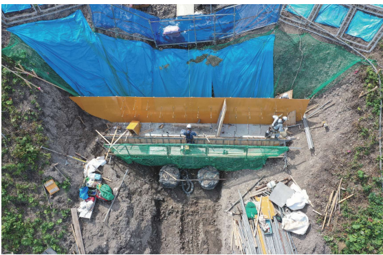
土留工の施工状況
