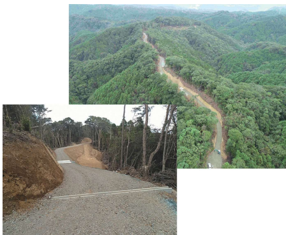
楠見229林道新設工事
