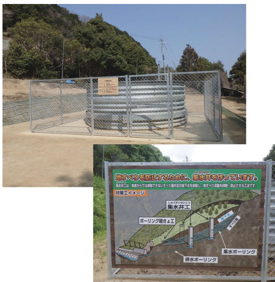
上秋津災害対策治山工事
