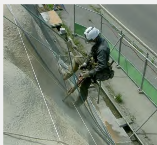
補強鉄筋工
