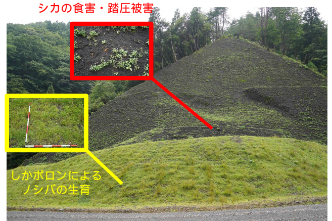
しかポロン（下部）と踏圧された植生基材吹付工（上部）
