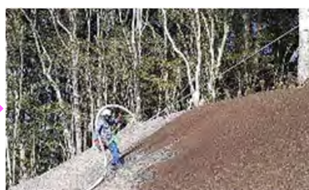
写真4：吹付作業 (21年12月撮影)
