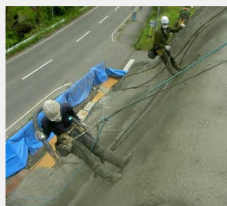
接着モルタル吹付工
