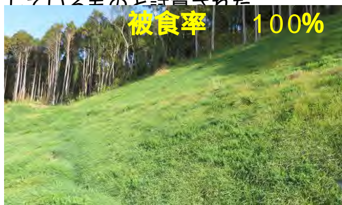
写真7：A工区の繁茂状況 (22年11月撮影)
