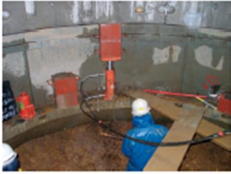
（ジャッキによる刃口押上げ）
