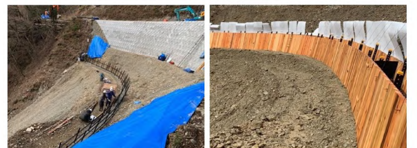
写真3 現場での作業状況（作業全体の52.6%）
