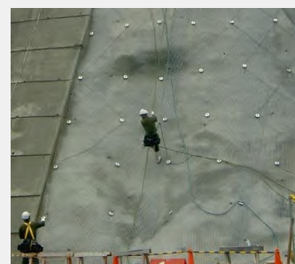
金網・ロープ設置工
