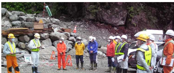
千田伸彦現場代理人の工事概要説明
