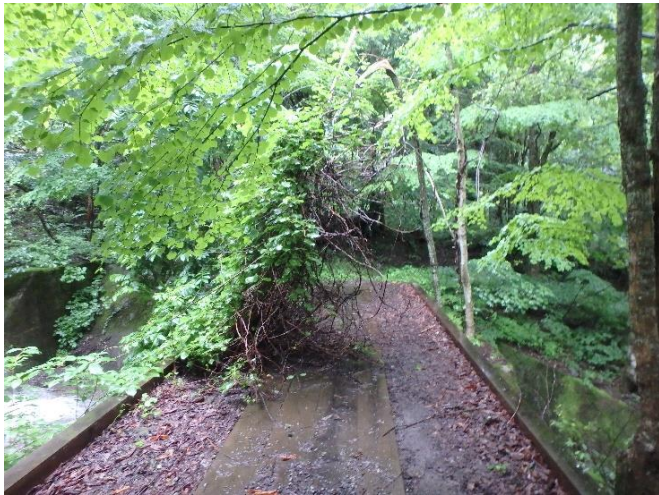
歩道途中の橋(作業前)
